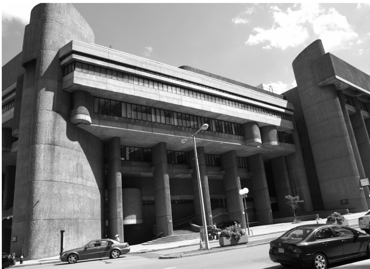
Ryc. 4. Fragment elewacji od strony Staniford Street; fot. autor Fig. 4. Detail of the facade from Staniford Street; photo: author
