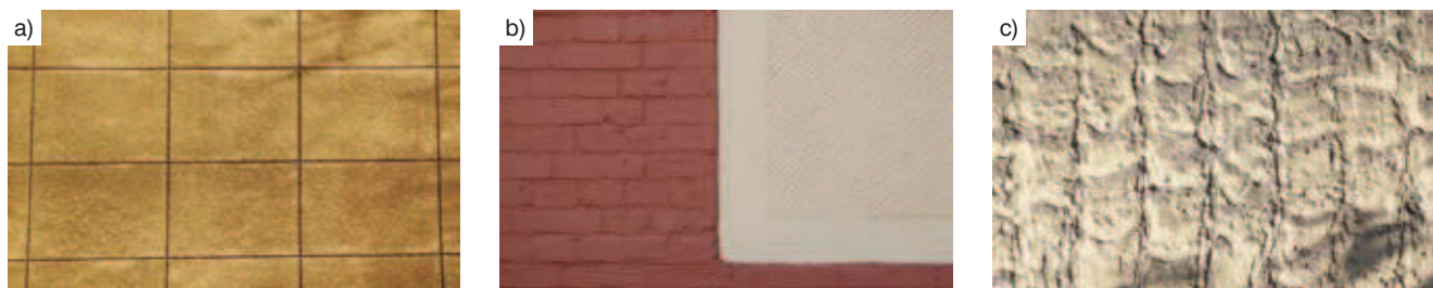
Rys. 2. Tynki nakrapiane: a) drobnziarniste za pomocą agregatu (popularny „baranek”), b) narzucane przez siatkę, c) narzucane za pomocą kielni
