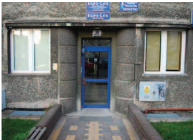
Rys. 14. Przykład zastosowania różnych rodzajów tynków: lico ściany – tynk zacierany; portal – tynk zmywalny połączony z tynkiem kamieniarskim gradzinowanym, Toruń ul. Moniuszki 30
