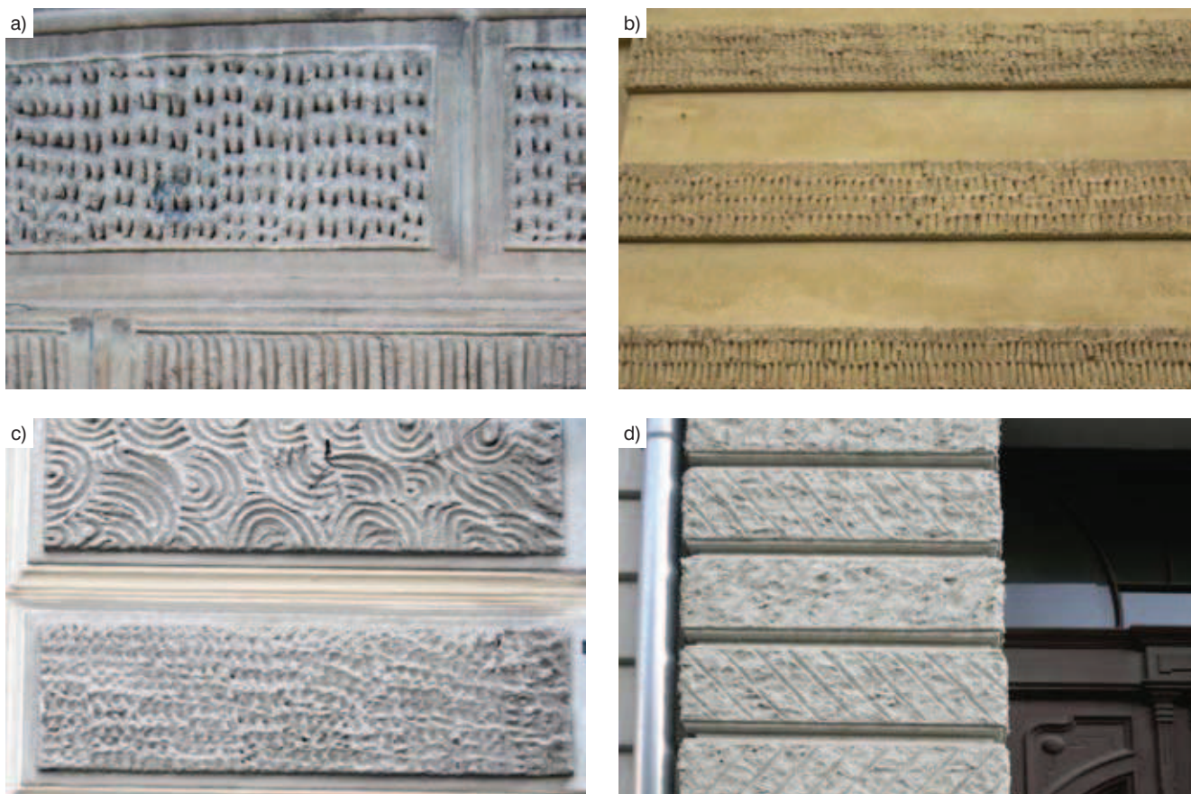
Rys. 6. Tynki fakturowane: a), b) wyciskane regularnie (widoczne ślady użytego narzędzia), c), d) wyciskane w fantazyjne wzory
