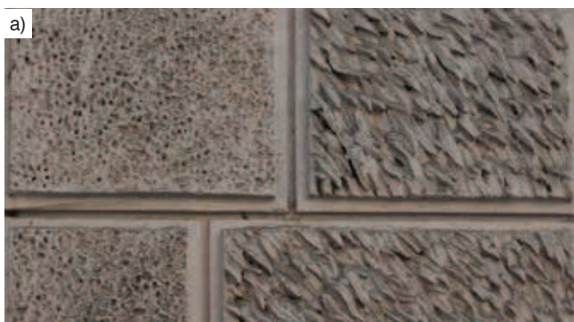
Rys. 9. Wykonane z narzutu tynki fakturowane imitujące kamień: a) za pomocą lancetu, b) narzucane szpachlą
