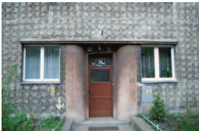
Rys. 7. Tynk gniazdkowany ( lico ściany )
