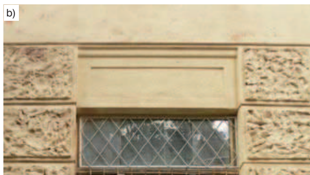
Rys. 9. Wykonane z narzutu tynki fakturowane imitujące kamień: a) za pomocą lancetu, b) narzucane szpachlą
