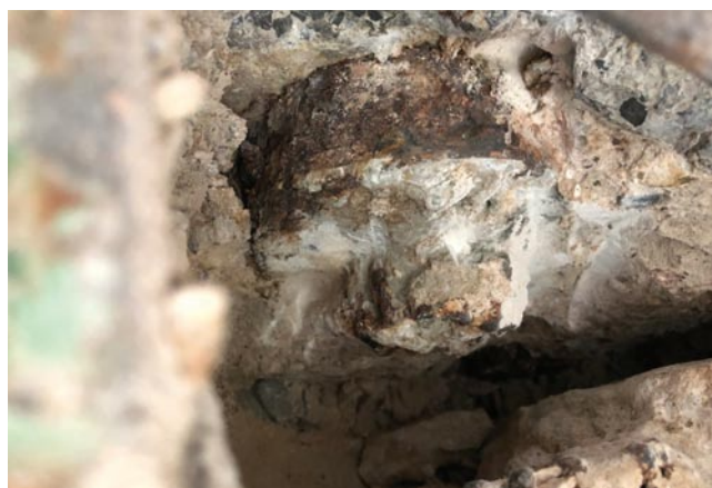
Rys. 2. Widok i przekrój zakotwienia z betonu (żelbetu)
