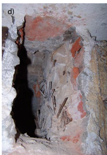
Rys. 5. Wybrane problemy w zakresie obetonowania bloków kotwiących: a) bardzo słaby beton, b, c) brak obetonowania, d) nasiąkliwy beton z kawałkami cegieł, e) szczelne obudowanie blachami, f) wspólne obetonowanie bloków kotwiących sąsiadujących dźwigarów
