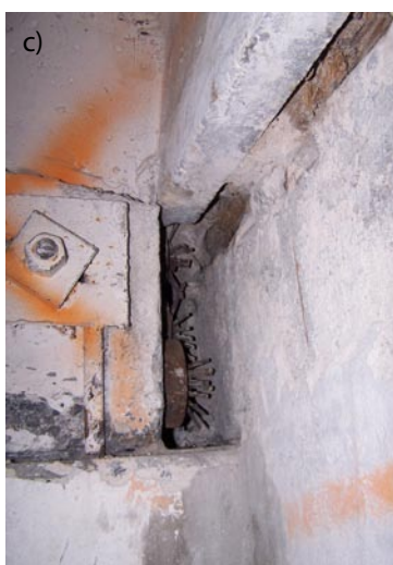
Rys. 5. Wybrane problemy w zakresie obetonowania bloków kotwiących: a) bardzo słaby beton, b, c) brak obetonowania, d) nasiąkliwy beton z kawałkami cegieł, e) szczelne obudowanie blachami, f) wspólne obetonowanie bloków kotwiących sąsiadujących dźwigarów
