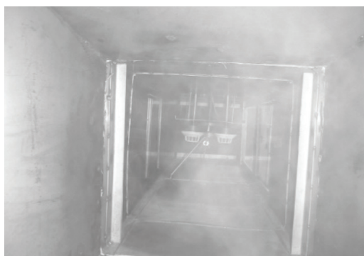
Rys. 4. Fotografia wyglądu wnętrza tunelu pomiarowego wraz elementami pomiarowymi (nie zadymiony i zadymiony) [4]
