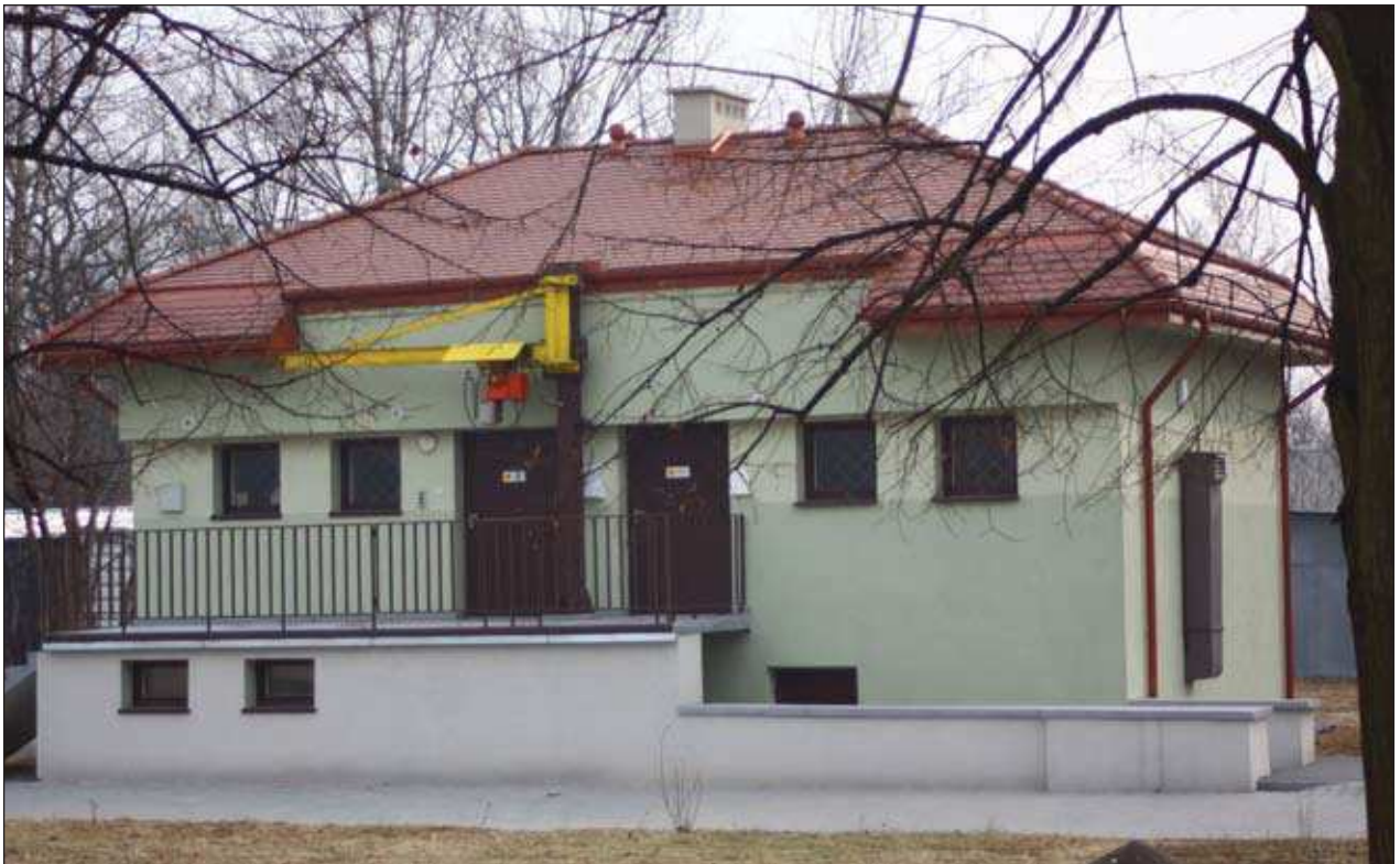
Fot. 4. Magazyn materiałów jądrowych i odpadów promieniotwórczych oraz źródeł promieniotwórczych
