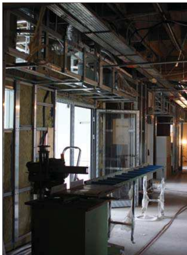
Fot. 3. Budowa instalacji w budynku laboratorium Centrum Radiochemii i Chemii Jądrowej na potrzeby energetyki jądrowej i medycyny nuklearnej
