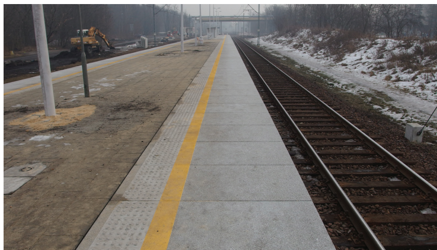
Fot. 12. Widok płyt peronowych NG zabudowanych na poligonie na stacji Będzin Ksawera
