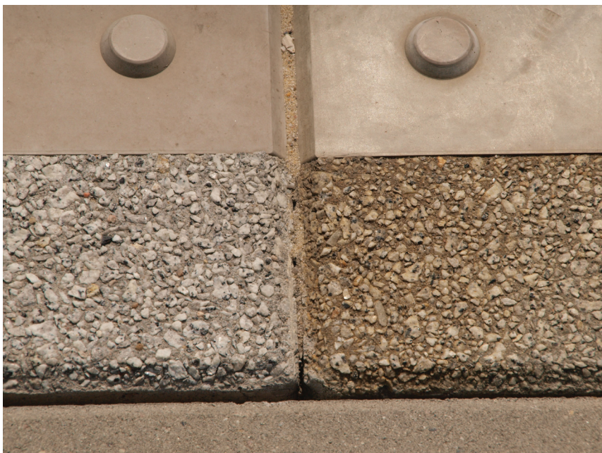
Fot. 15. Widok faktury powierzchni betonowej płyt peronowych NG zabudowanych na poligonie na stacji Będzin Ksawera. Po prawej stronie widoczna płyta po programie przed modyfikacją składu chemicznego pasów ostrzegawczych, po lewej stronie płyta po modyfikacji
