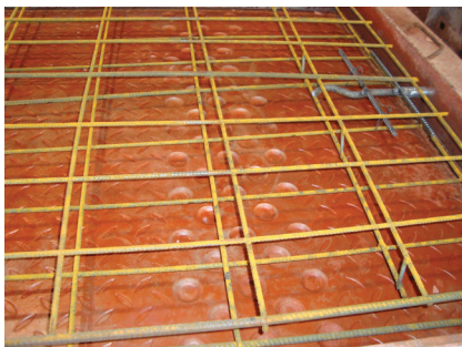
Fot. 5 i 6. Forma stalowa przygotowana do wykonania betonowej płyty peronowej – widoczna charakterystyczna faktura wierzchniej powierzchni płyty (negatyw) oraz podwójna siatka zbrojeniowa z prętów żebrowanych i po wypełnieniu betonem
