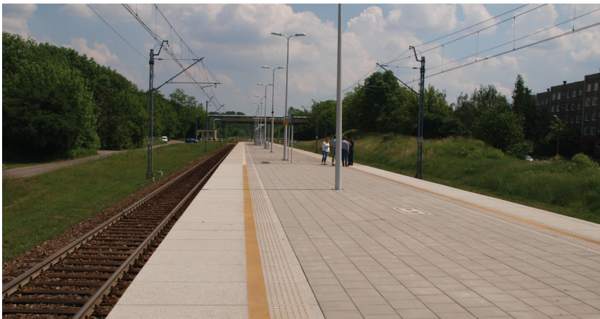
Fot. 14. Widok płyt peronowych NG zabudowanych na poligonie na stacji Będzin Ksawera po zakończeniu programu, na pierwszym planie widoczne płyty przed modyfikacją składu chemicznego pasów ostrzegawczych, na drugim po modyfikacji
