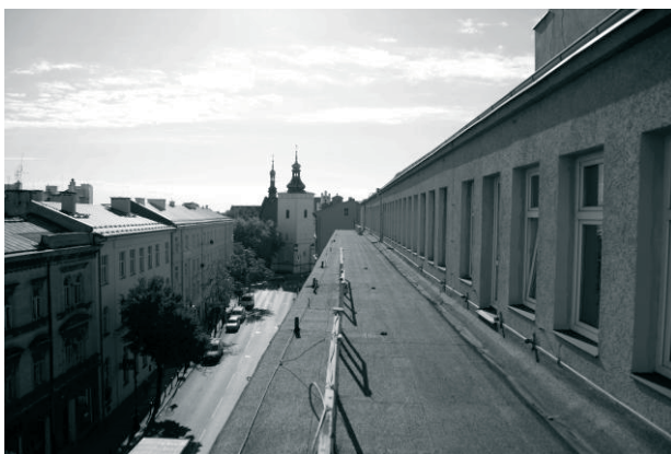
Rys. 3. Widok na Kościół Rektoralny z dachu trzeciej kondygnacji tworzącej nawis od strony ul. Kapucyńskiej. W tle widać Kościół Rektoralny na zamknięciu osi kompozycyjnej. (fot. Autor)
