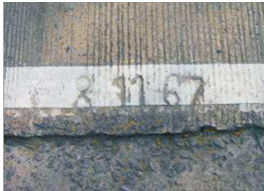
Rys. 6. Droga o nawierzchni betonowej CRCP, wybudowana w 1967 r. Fotografia wykonana w 2006 r. [15]
