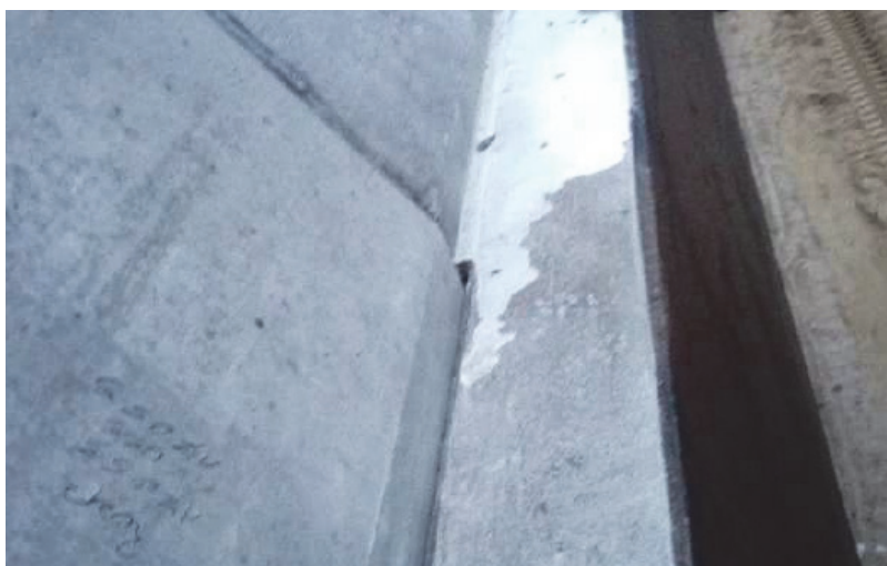
Rys. 6. Widok na podporę elementu z podlewką i bez podlewki
