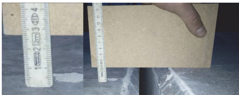
Rys. 7. Różnice przemieszczenia pomiędzy elementem zabezpieczonym i niezabezpieczonym
