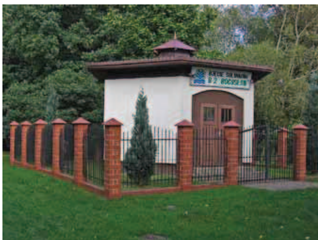
Fig.6. Brine well B-2 (Bogusław) in Kołobrzeg, phot. A. Krawiec • Ujęcie solanki B-2 (Bogusław) w Kołobrzegu, fot. A. Krawiec
