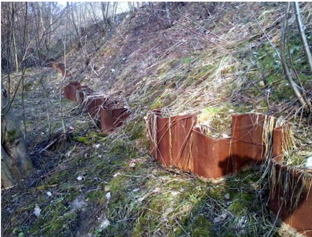
Rys. 1. Skarpa istniejącego nasypu drogi krajowej (Dokumentacja geologiczno-inżynierska, 2011)
