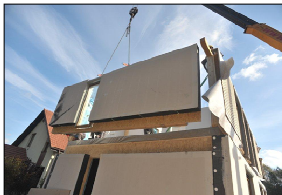
Rys. 6. Montaż ścian zewnętrznych [4]
