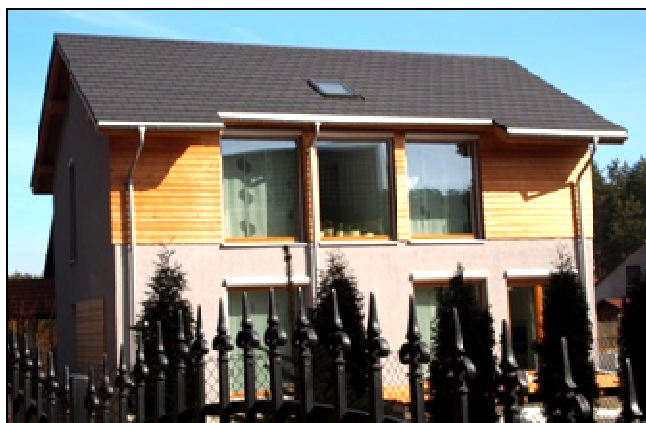
Rys. 3. Południowa elewacja budynku pasywnego w Boruszowicach [4]
