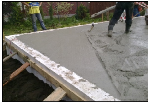
Rys. 4. Wykonanie płyty fundamentowej [4]
