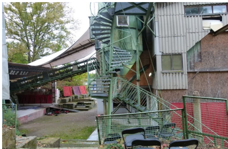
Rys. 9.6 Art Kieswerk w Weil nad Renem w Niemczech.
