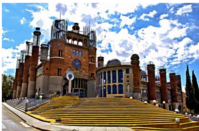
Rys. 9.5 Katedra Justo w Mejorada del Campo pod Madrytem. Kościół budowany z materiałów rozbiórkowych i odpadów
