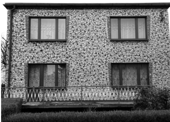
Rys. 9.10 Dom prywatny w Bojkowie, przykład wykorzystania odpadów ceramicznych jako okładziny elewacyjnej
