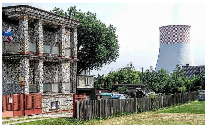
Rys. 9.9 Dom prywatny w Rybniku, przykład wykorzystania odpadów ceramicznych jako okładziny elewacyjnej
