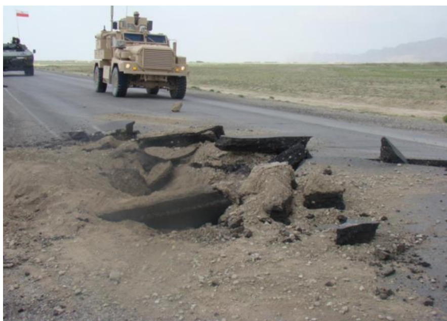
Rys. 2. Jezdnia uszkodzona po jednym z ataków IED
