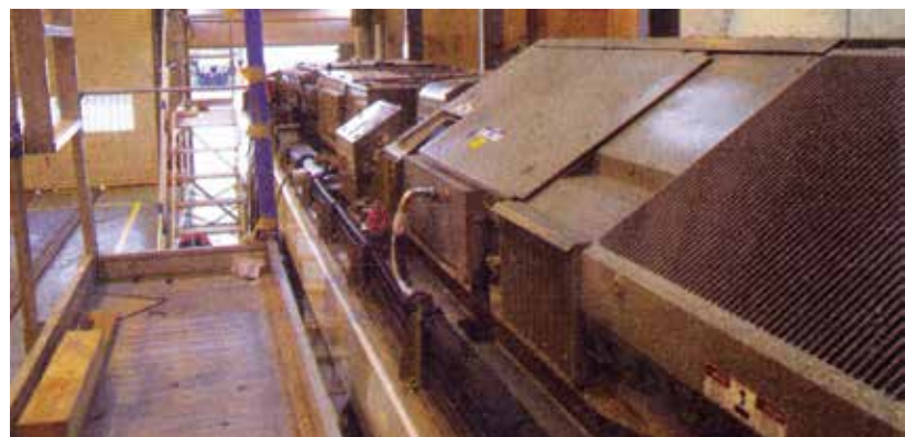
Agregat PP MTU i falowniki są montowane członach tylnych w pojazdach dla Chemnitz. Fot. H. Hondius
