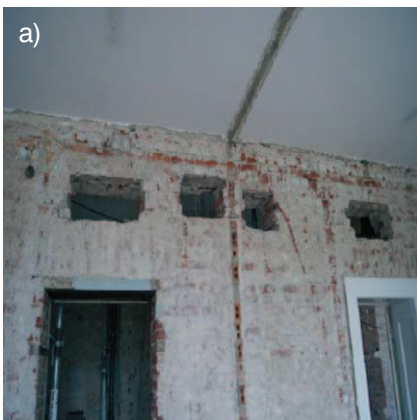
Rys. 3. Oslabienie ścian konstrukcyjnych w miejscach: a) prowadzenia kanałów wentylacyjnych, b) prowadzenia rur i przewodów instalacji kanalizacyjnej, elektrycznej itp.
