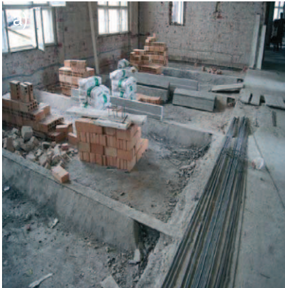
Rys. 2. Strop w części użytkowej: a) konstrukcja stropu po usunięciu warstw wykończeniowych, b) oparcie stropu na ścianie wewnętrznej nośnej
