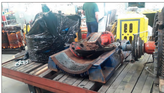
Rys. 1. Łapy silnika oderwane od pozostałej części korpusu
