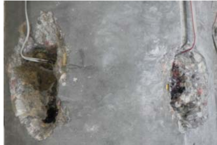
Fot. 9. Tensometry elektrooporowe naklejone na stali sprężającej – widok ogólny Photo 9. Strain gauges pasted on prestressing steel - general view
