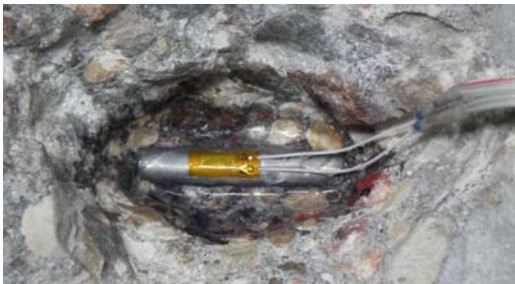
Fot. 8. Tensometr elektrooporowy naklejony na stali sprężającej – szczegół Photo 8. Strain gauge pasted on prestressing steel – detail
