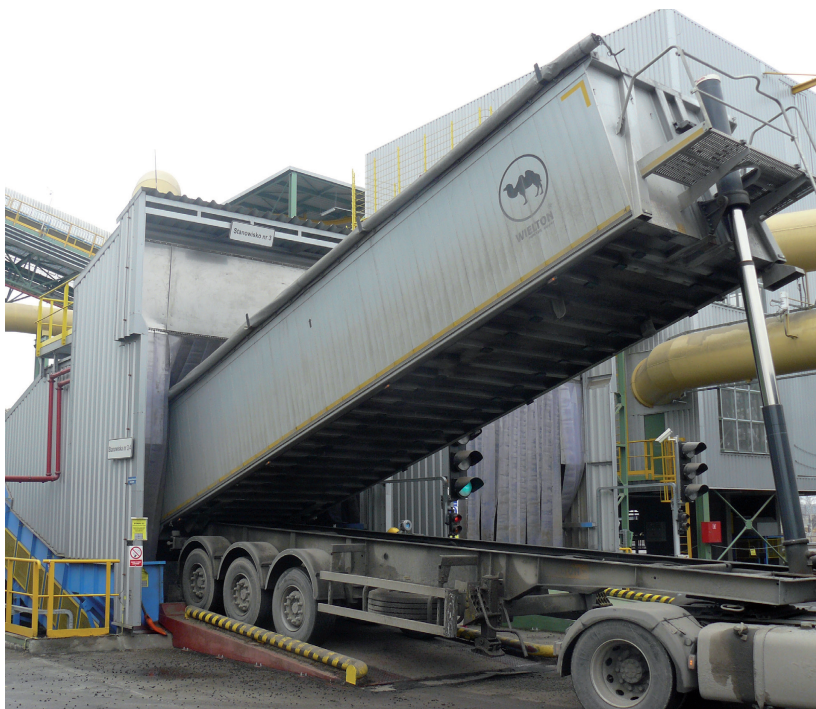
Fot. 3. Elektrownia Połaniec - rozładunek dostawy biomasy pochodzenia rolniczego
