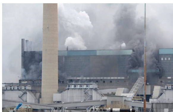
Fot. 1. i Fot. 2. Przykładowe pożary w elektrowniach zawodowych
