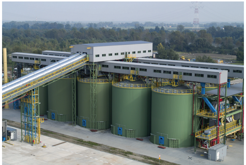
Fot. 4. Elektrownia Połaniec - instalacja zbiorników magazynowych biomasy pochodzenia rolniczego
