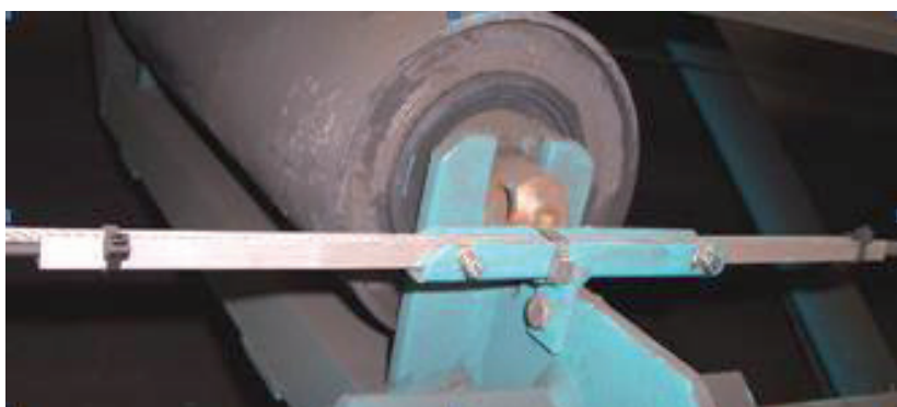
Fot. 11. Mocowanie kabla światłowodowego
