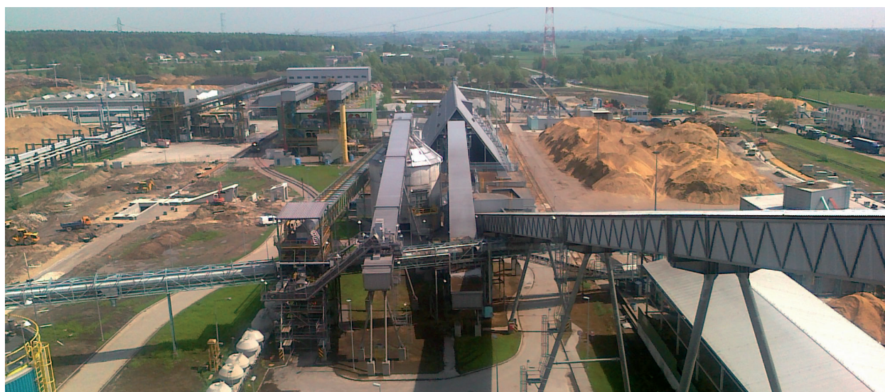
Fot. 5. Elektrownia Potaniec - widok ogólny na linie transportowe biomasy
