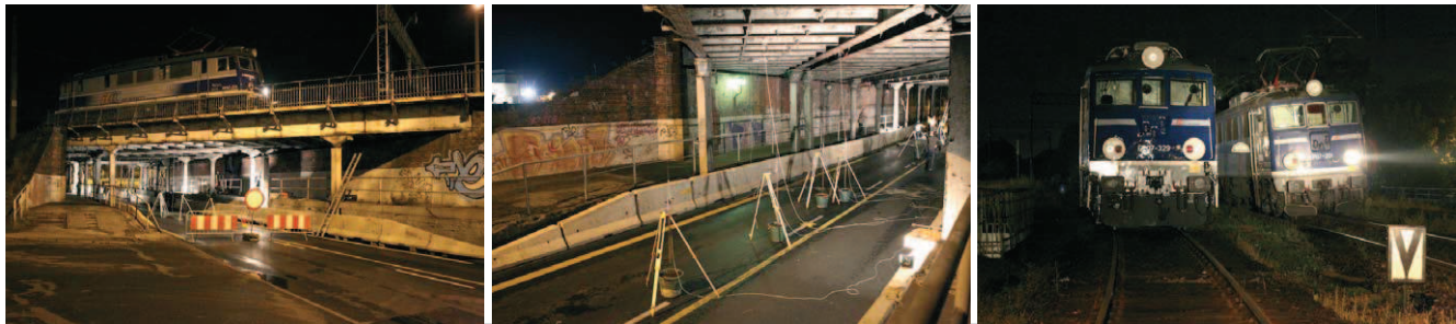
Rys. 6. Próbné obciążenie obiektu
