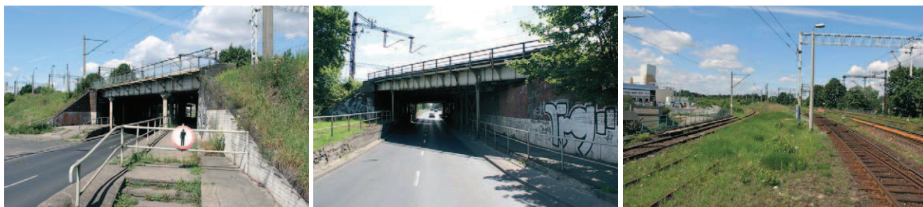
Rys. 1. Widok ogólny wiaduktu
