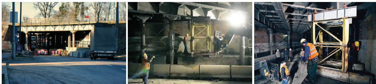
Rys. 9. Zabezpieczenie obiektu – tymczasowe podparcie konstrukcji przęseł [7]
