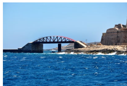
Widok z morza w okolicy fortu St. Elmo na stalowy most dla pieszych i falochron (obiekt nr 3)
