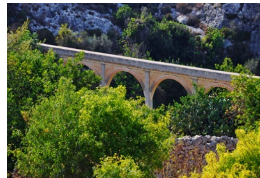
Łukowa konstrukcja nośna akweduktu w Moście (obiekt nr 9)
