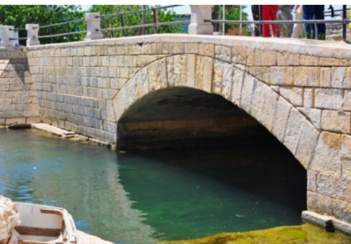
Jednoprzęsłowy most kamienny na wyspę Manoel przez zatokę Sliema (obiekt nr 1)
