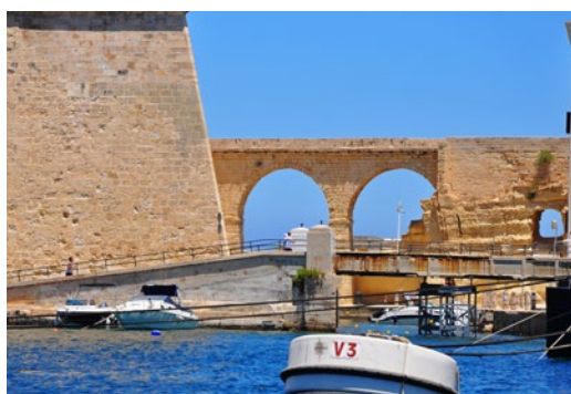
Arkadowe przejście w murach fortecznych (obiekt nr 4)
