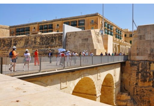
Kamienny most tukowy przez dawną fosę miejską Valletty (obiekt nr 5)
