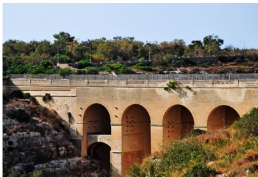
Łukowy most kamienny w Moście (obiekt nr 8)
