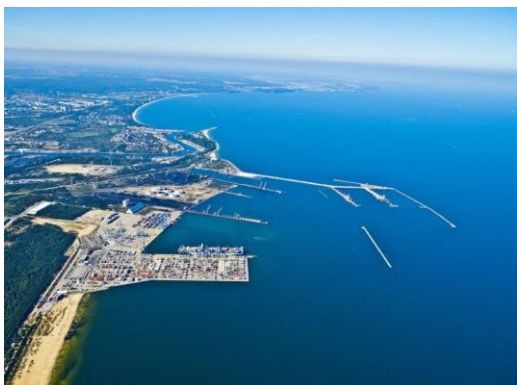
Rys.1. Baza Paliw Płynnych Naftoport [10]
