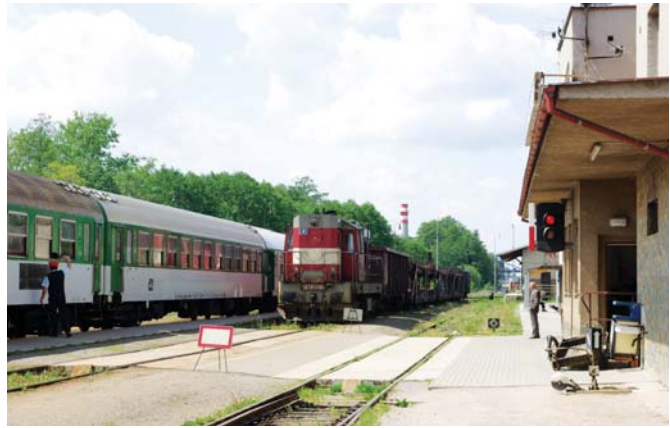
Fot. 7. Przenośne tarcze zatrzymania ustawione przed dojściem na peron na czas pobytu w stacji pociągu pasażerskiego (Častolovice). Fot. W. Gąsior
