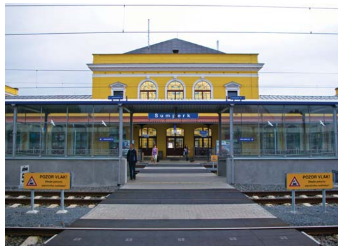
Fot. 5. Dojście na perony w poziomie torów na wprost wyjścia z poczekalni na stacji Šumperk. Fot. W. Gąsior
