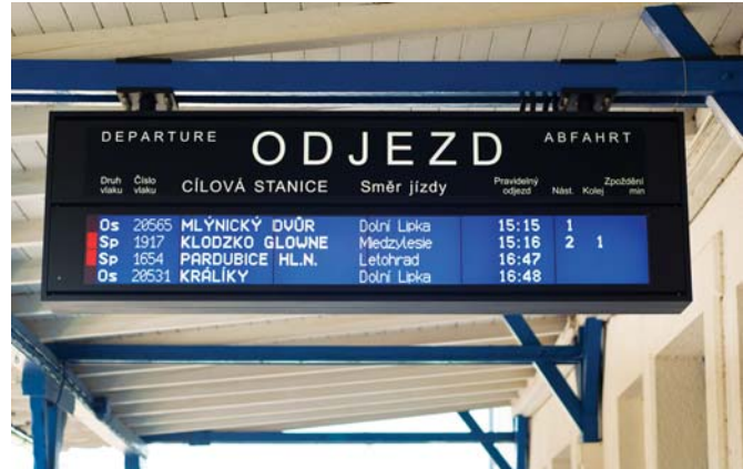
Fot. 12. Tabulka LCD na malé staci. Uwagę zwraca wyróżnienie pociągów zatrzymujących się tylko na wyznaczonych stacjach (tutaj: przyspieszonych) kolorowym prostokątem na monochromatycznej tabulce. Kolor czerwony uzyskiwany jest dzięki naklejeniu półprzezroczystej folii w pierwszej kolumnie obszaru przeznaczzonego na informację o kategorii pociągu (Lichkov). Fot. W. Gašior
