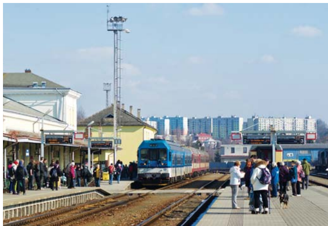
Fot. 4. Układ peronów na stacji Turnov. Widoczne jest dojście na perony w poziomie torów oraz umieszczone przed nim tarcze zastrzeżenia (biały prostokąt w czerwonej obwódce). Fot. W. Gąsior
