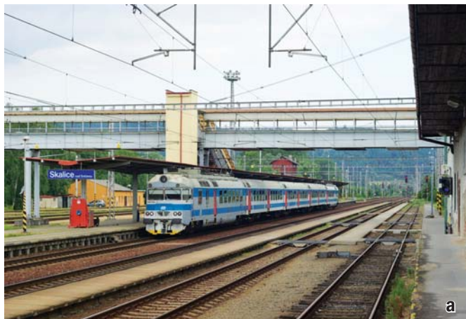
Fot. 3. Wąskie perony: a – przy grupie torów po stronie budynku dworcowego oraz szeroki peron z bezkolizyjnym dojściem nadziemnym (Skalice nad Svitavou, magistrala Praga–Česká Třebová–Brno); b – dzięki istnieniu przejść w poziomie torów pomiędzy wąskimi peronami zlokalizowanymi po stronie budynku dworcowego zapewniono krótkie drogi dojścia pomiędzy skomunikowanymi pociągami. Dla przedstawionej na zdjęciu konfiguracji pociągów czas skomunikowania wynosi 2 minuty. Dla przeciwnego kierunku, w związku z koniecznością pokonania dłuższej drogi przez przejście podziemne, najkrótszy czas skomunikowania wynosi 4 minuty [2] (Moravský Písek, magistrala Přerov–Břeclav). Fot. W. Gąsior
