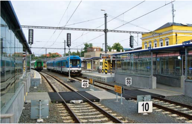
Fot. 6. Ograniczenie prędkości dotyczące wyłącznie czoła pociągu w rejonie przejścia na perony (Šumperk). Rozwiązanie takie pozwala na rezygnację z montażu sygnalizacji dla pieszych. Fot. W. Gąsior
