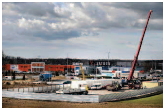
Rys. 4. W tle widok na hale OBI Saturn w Tychach (źródło: http://katowice.wyborcza.pl )
