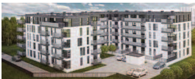
Rys. 6. Melody Park przy ulicy Chodkiewicza 13 w Bydgoszczy – budowa i wizualizacja (źródło: http://bydgoszcz.wyborcza.pl )
