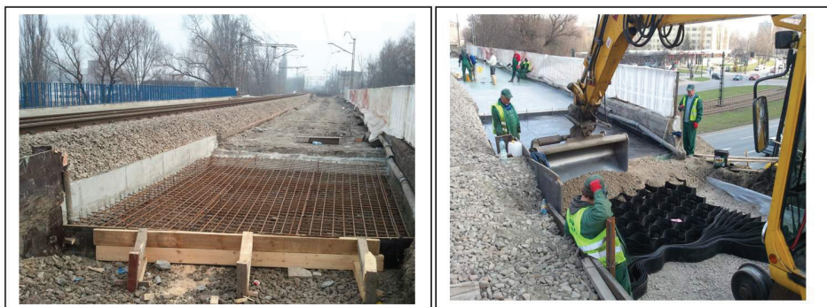
Fot. 1. Wykonanie strefy przejściowej przy obiekcie nr 1 (wiadukt betonowy (płyta przejściowa))
