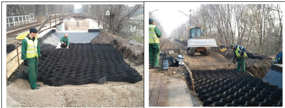
Fot. 2. Wykonanie strefy przejściowej (wiadukty z jazdą na mostownicach): a) obiekt nr 2, b) obiekt nr 3, klin z geokraty i zasyпки stabilizowanej cementem
