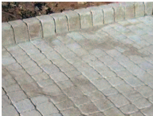
Rys. 15. Zalecane kształty krawężników na terenach górniczych [12]
