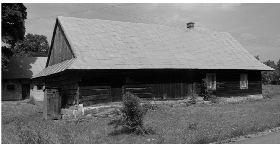
Rys. 1. Chata łemkowska ze zmienionym pokryciem dachowym, Bartne nr 18, fot. A. Mikrut, 06. 2015
