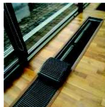
Rys. 1. Przykład grzejnika podłogowego wraz z kratką maskującą [2]
