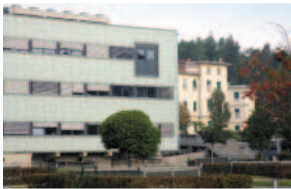
Ryc. 6. Nowe obiekty wchodzą w rodzaj dialogu z istniejącą architekturą Fig. 6. The new buildings create a kind of dialogue with the existing architecture
