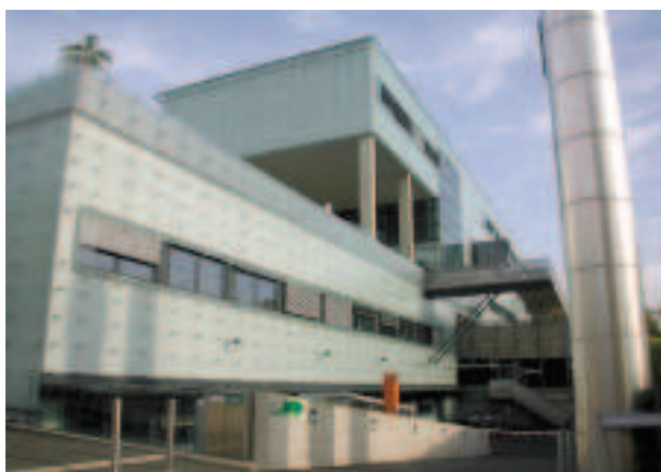
Ryc. 3. Fragment fasady zachodniej Fig. 3. A fragment of the western facade
