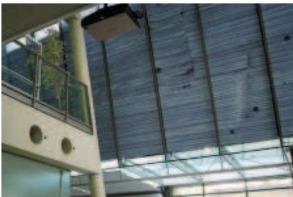
Ryc. 10. Okrywająca okna charakterystyczna faktura ogranicza dostęp światła Fig. 10. A characteristic facture covers the windows and restricts access of light
