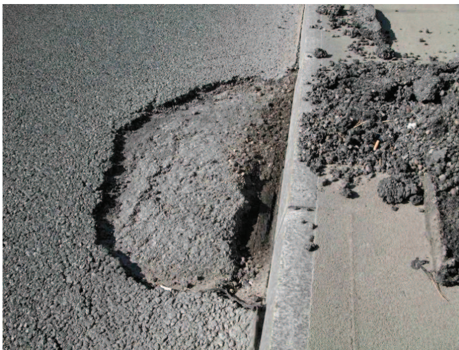
Rys. 1. Widok pęcherza („starego typu”) przy krawężniku po usunięciu zniszczonej warstwy ścieralnej; pęcherz był wypełniony wodą
