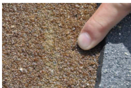
Rys. 11. Obiekt 4; podłoże zagruntowane żywicą epoksydową po usunięciu papy w miejscu pęcherza
