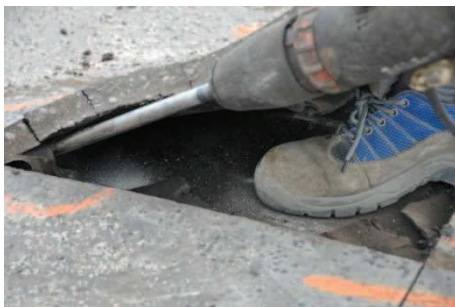
Rys. 8. Obiekt 3; zdejmowanie nawierzchni i izolacji po powstaniu pęcherza
