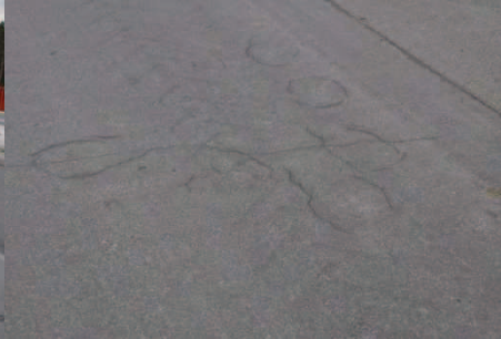
Rys. 5. Obiekt 8; spękana warstwa wiążąca nawierzchni nad pęcherzami pod izolacją
