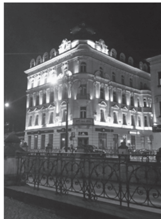
il. 14. Budynek zespołu mieszkaniowego „Browar Lubicz” Pałac Goetzów; widok iluminacji elewacji kamienicy w 2017 r. / housing complex group “Browar Lubicz” Pałac Goetzów view of the facade illumination in the 2017 il. 15. Kamienica przy ul. Radziwiłłowskiej 33; widok iluminacji elewacji kamienicy w 2017 r. / tenement house at Radziwiłłowska 33/35 Street, view of the illumination of the facade of the building in 2017
