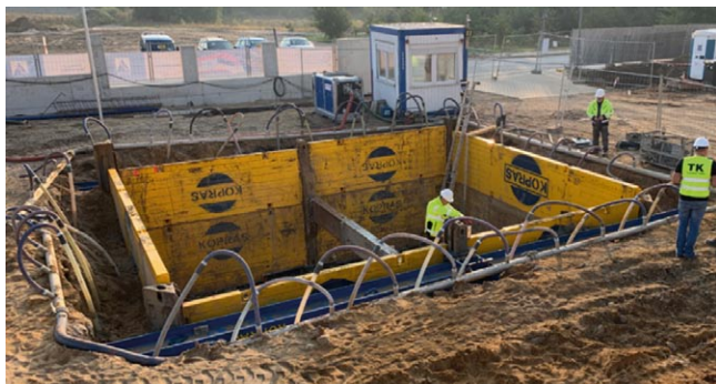
Rys. 8. Punkтова obudowa słupowo-płytowa
