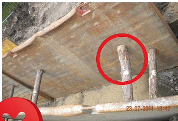
Rys. 16. Należy stosować rozwiązania systemowe, rozpory systemowe
