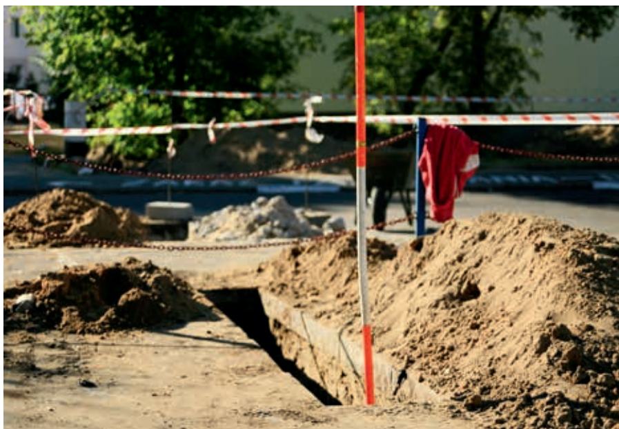
Wykonany wykop – start i koniec
