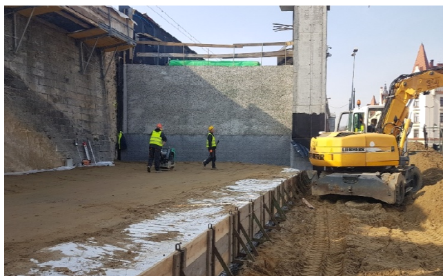
Rys. 4. Realizacja ściany oporowej z licem biernym, Kraków, linia kolejowa E30
