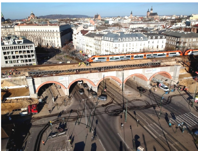
Rys. 3. Realizacja ściany oporowej z licem biernym, Kraków, linia kolejowa E30
