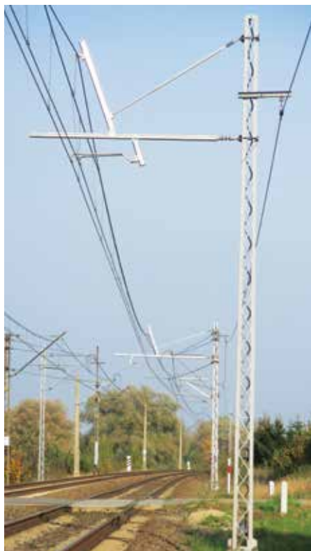
Fot. 1. Systemy podwieszenia sieci jezdnej firmy Mabo Sp. z o.o. zainstalowane na linii 273
