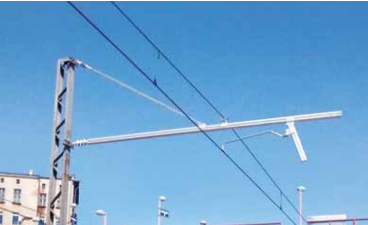
Fot. 6. Podwieszenie obniżone na stacji Szczecin Główny – odsuw od słupa
