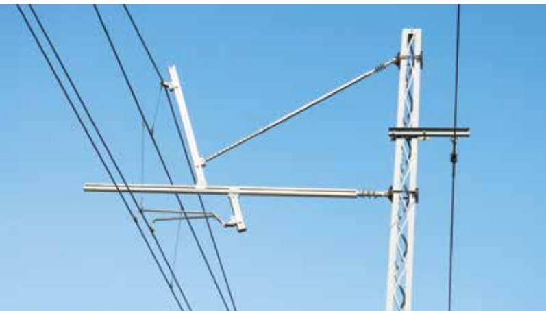
Fot. 2. Podwieszenie przelotowe na linii 273 – odsuwnie do słupa
