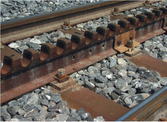
Zębatka systemu Struba, AB / Stoss, Szwajcaria (24.05.2008 r.) fot. Hans Hug
