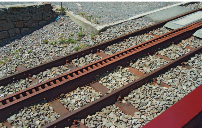
Zębatka systemu Riggenbacha, Rigi-Bahn, Szwajcaria (19.05.2009 r.) Fot. Hans Hug
