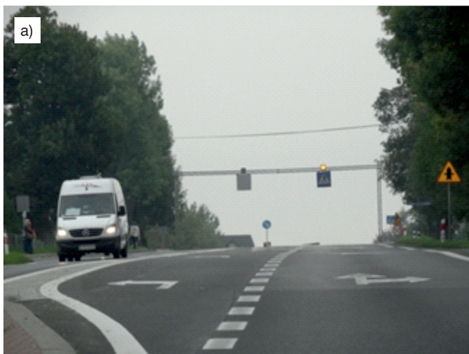
Fot. 2. Przykłady informowania o zbliżaniu się do niewidocznego przejścia dla pieszych Źródło: a) fot. M. Kieć, b) fot. K. Jamroz
