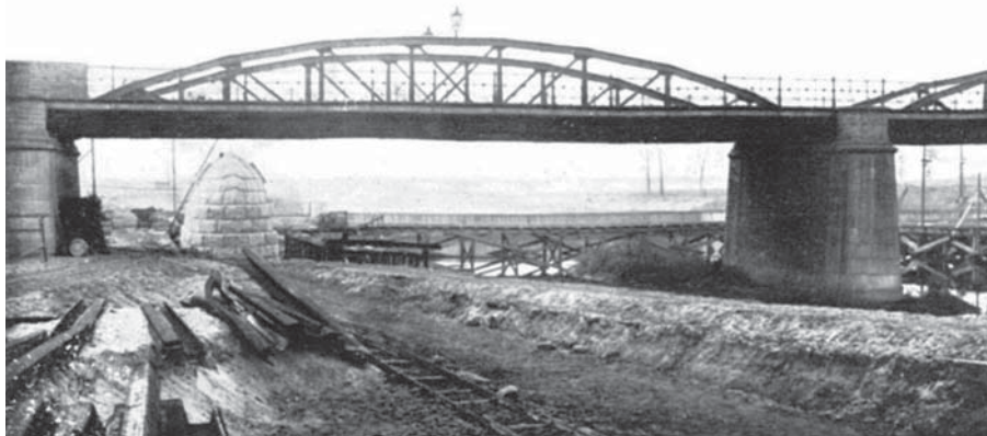
Fot. 1. Skrajne przęsło starego Rosenthaler Brücke z 1873 r., po lewej w tle filar nowego mostu Północnego [2]
