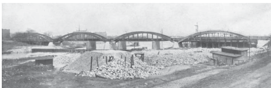
Fot. 7. Montaż łukowych dźwigarów głównych na ukończeniu [2]
