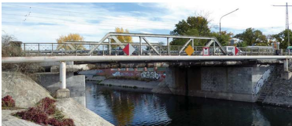
Fot. 2. Współczesny widok mostu Trzebnickiego Południowego od strony wody dolnej
