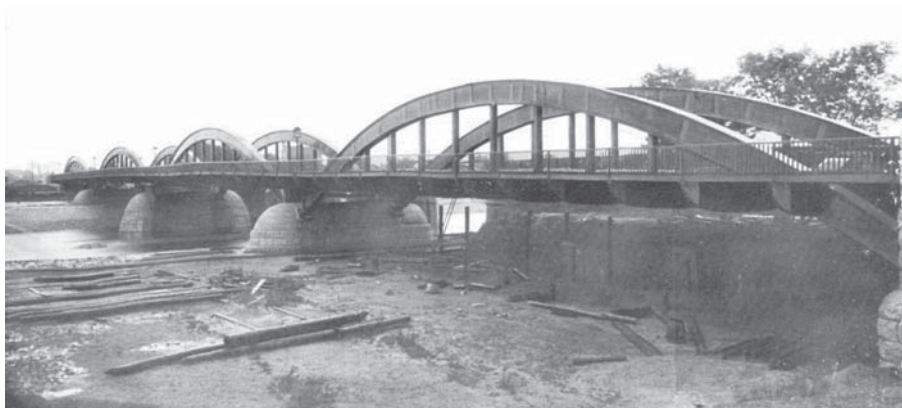
Fot. 8. Nowy Rosenthaler Brücke niedługo przed oddaniem do użytkowania [2]
