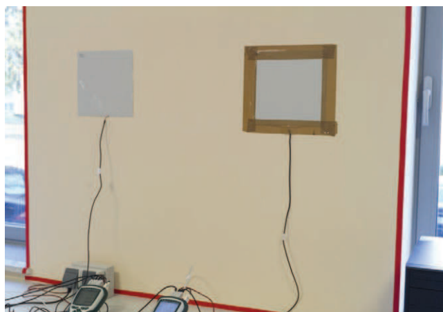
Rys. 2. Czujniki płytowe typu termopara zainstalowane na ścianie budynku Uniwersytetu Warmińsko-Mazurskiego w Olsztynie. Poniżej widoczne rejestratory danych. Kolejnym etapem instalowania aparatury pomiarowej jest mocowanie czujników temperatury (fot. autor)
