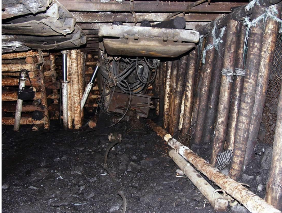
Rys. 4. „Seksja asekuracyjna” usytuowana wzdłuż likwidowanej ściany [10]
