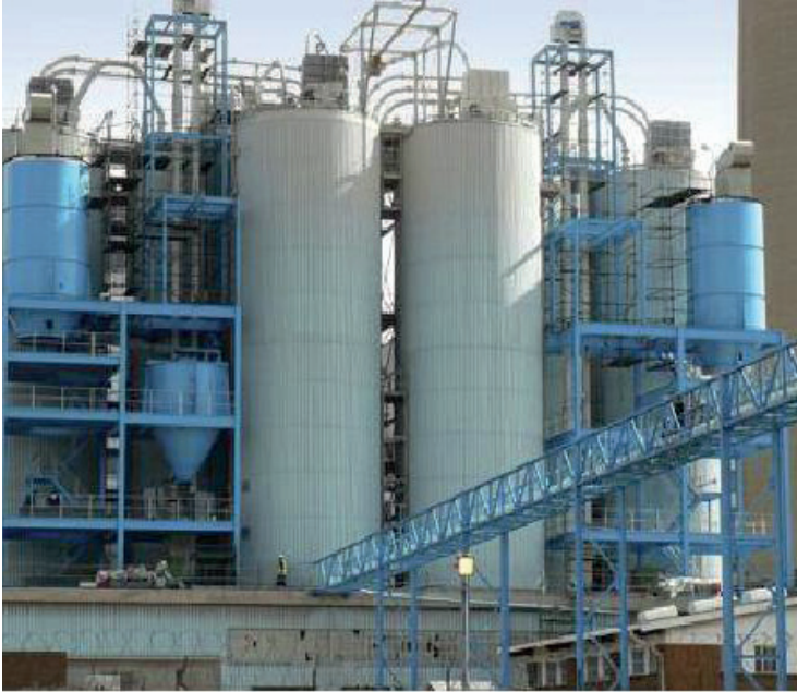
Rys. 10. Instalacje klasyfikacji popiołów lotnych i produkcji popiołów kwalifikowanych. a – typowy projekt firmy Batemann instalacji klasyfikacji popiołów lotnych wkomponowanych w stacje ich składowania, zrealizowany w elektrowni w Hong Kongu; b – Ulula Ash plant at Kreil power station, South Africa
