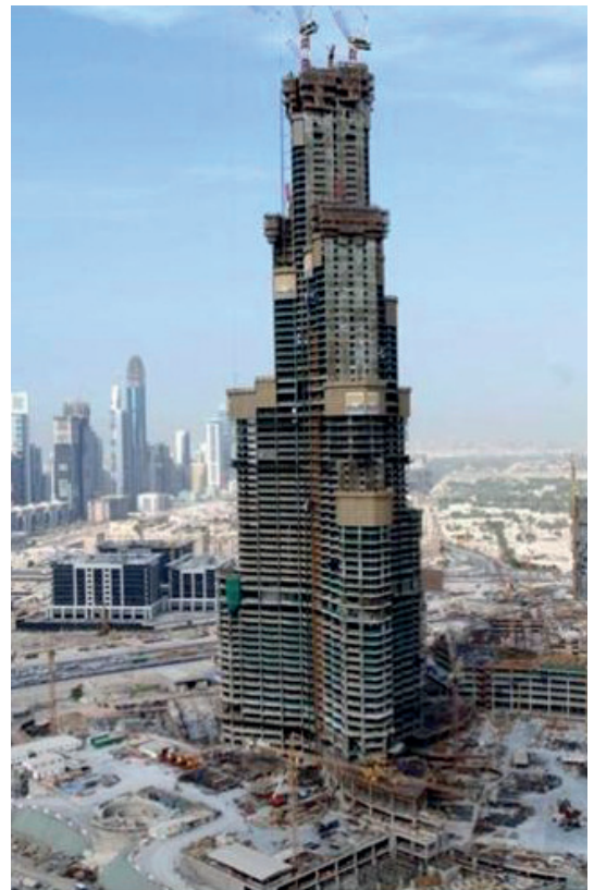
Rys. 11. Zdjęcie najwyższego drapacza chmur świata w czasie budowy gdzie stosowano popioły kwalifikowane
