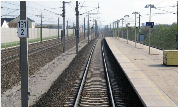
Rys. 8. Kolej Zachodnia rozbudowana do układu czterotorowego; linia do ruchu dalekobieżnego ( V = 200 km/h) – po lewej, linia do pasażerskiego ruchu regionalnego i ruchu towarowego – po prawej [fot. A. Massel]
