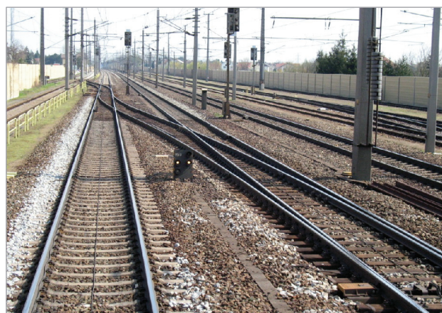
Rys. 7. Stacja Marchtrenk na odcinku Linz – Wels zmodernizowanym w 1993 roku do prędkości 200 km/h [fot. A. Massel]
