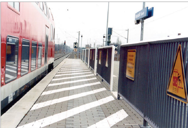
Rys. 5. Bariery na peronie przy torze głównym zasadniczym na linii Berlin – Hamburg [fot. A. Massel]
