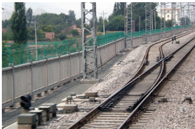
Rys. 10. Wygradzenie torów oraz rozjazd z ruchomym dziobem na zmodernizowanym odcinku linii w Chinach [fot. A. Massel]
