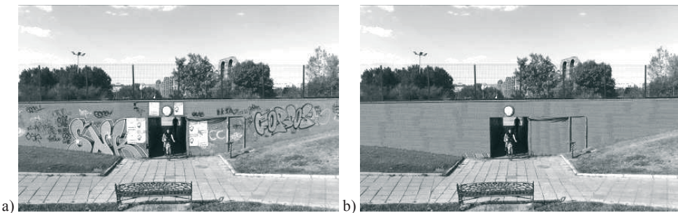
Rys. 7. Tunel przejścia dla pieszych przez nasyp kolejowy, Mérida, Hiszpania: a) stan istniejący b) sztuczny obraz z usuniętym graffiti
