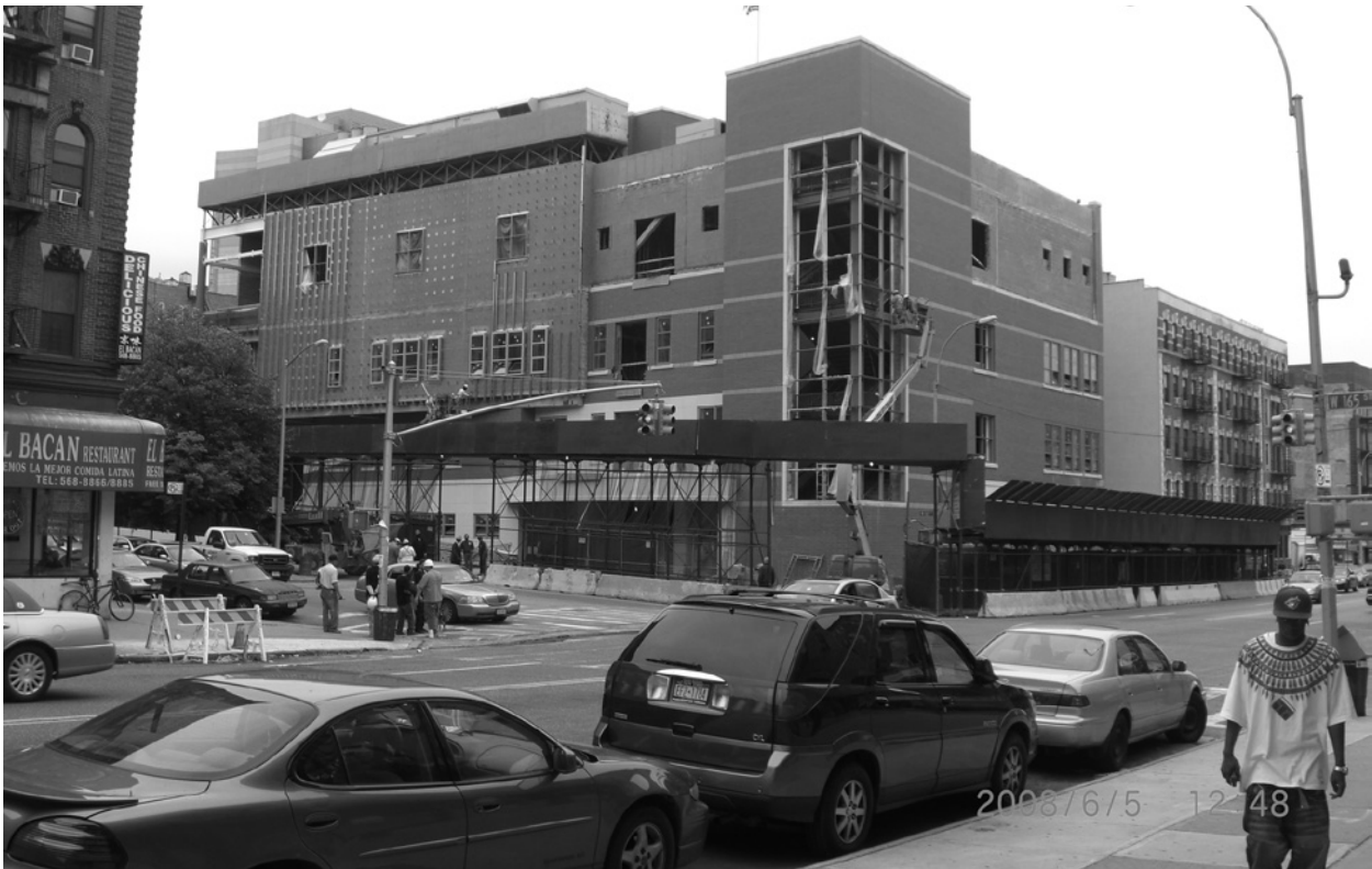
Ryc. 12. Szkoła Gregorio Luperon High School na Manhattanie w budowie; architekt: Purcell Architects. Fot. autor, 2008
