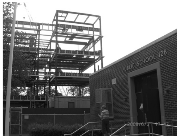
Ryc. 7. Rozbudowa szkoły PS 128Q. Widoczna konstrukcja stalowa nowego budynku. Fot. autor, 2008
