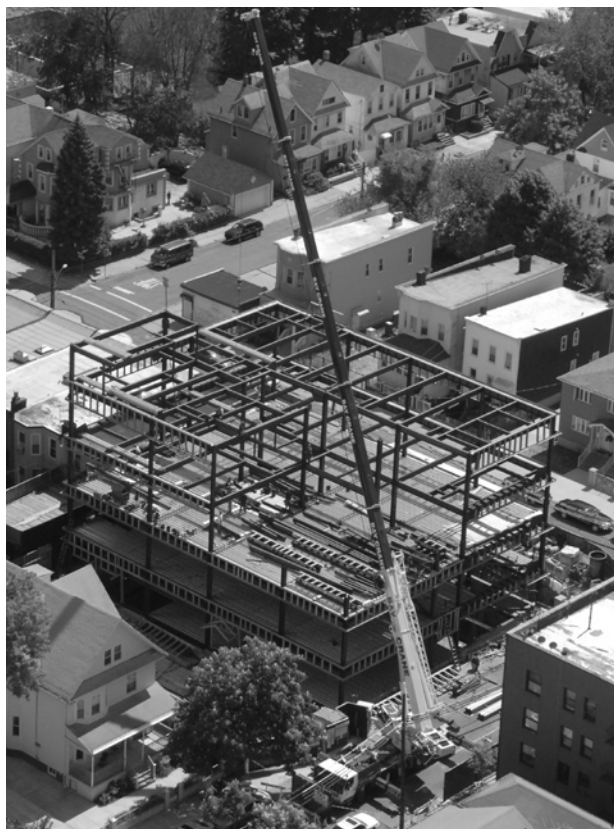
Ryc. 6. Konstrukcja stalowa budynku szkoły PS 273Q. Fot. autor, 2009
