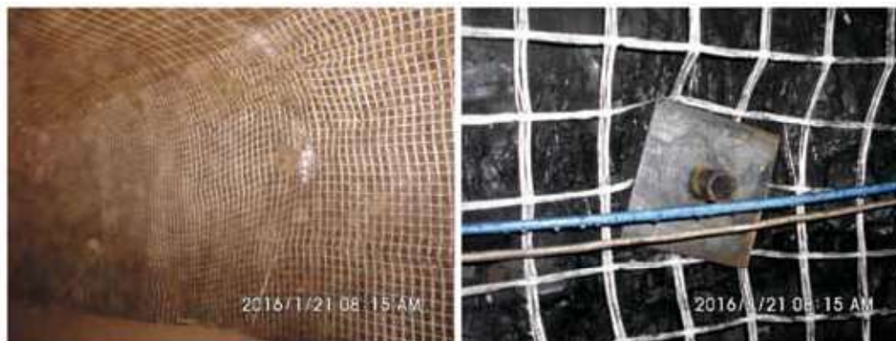
Rys. 20. Siatka typu SGG w obudowie kotwowej Fig. 20. Mesh type SGG in an anchor support
