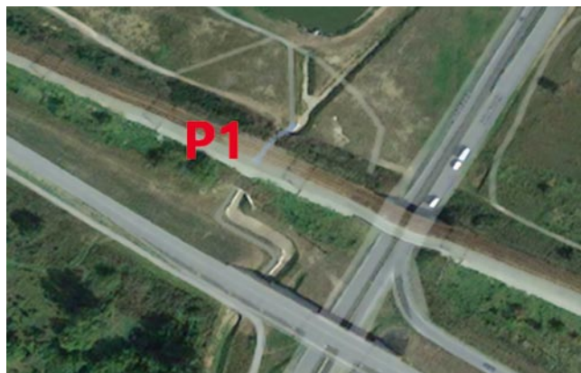
Rys. 2. Ogólny widok usytuowania obiektu inżynierskiego P1
