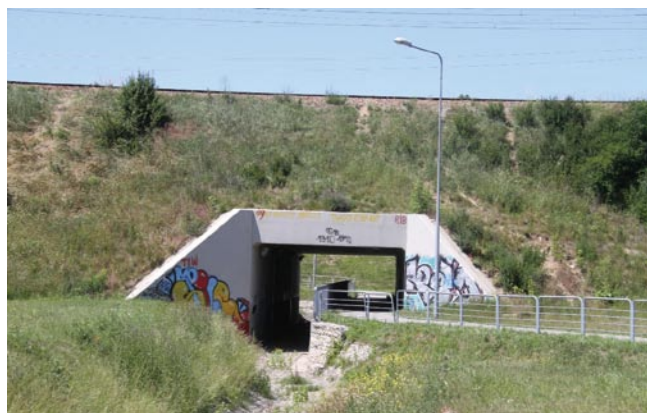
Rys. 1. Widok zrealizowanego przejścia pod torami
