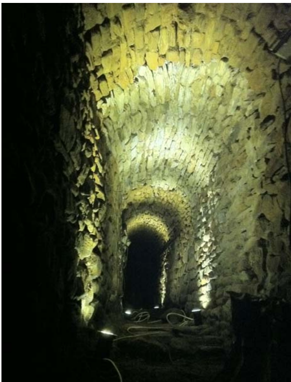
Ryc. 5. Kolektor sanitarny w trakcie prac. Fot. M. Piórkowski Fig. 5. Collector sewer during renovation work. Photo: M. Piórkowski
