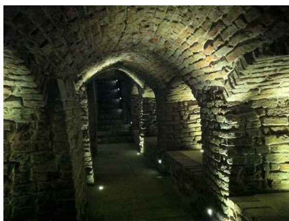
Ryc. 2. Piwnice pod budynkiem Rynek 1 w trakcie wykonywanych prac remontowo-konserwatorskich. Fot. M. Piórkowski
