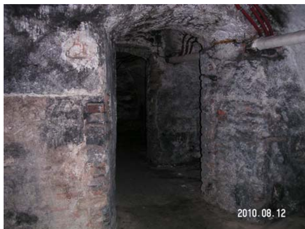
Ryc. 1. Piwnice pod budynkiem Magistratu w Przemysłu przed remontem. Fot. M. Piórkowski
