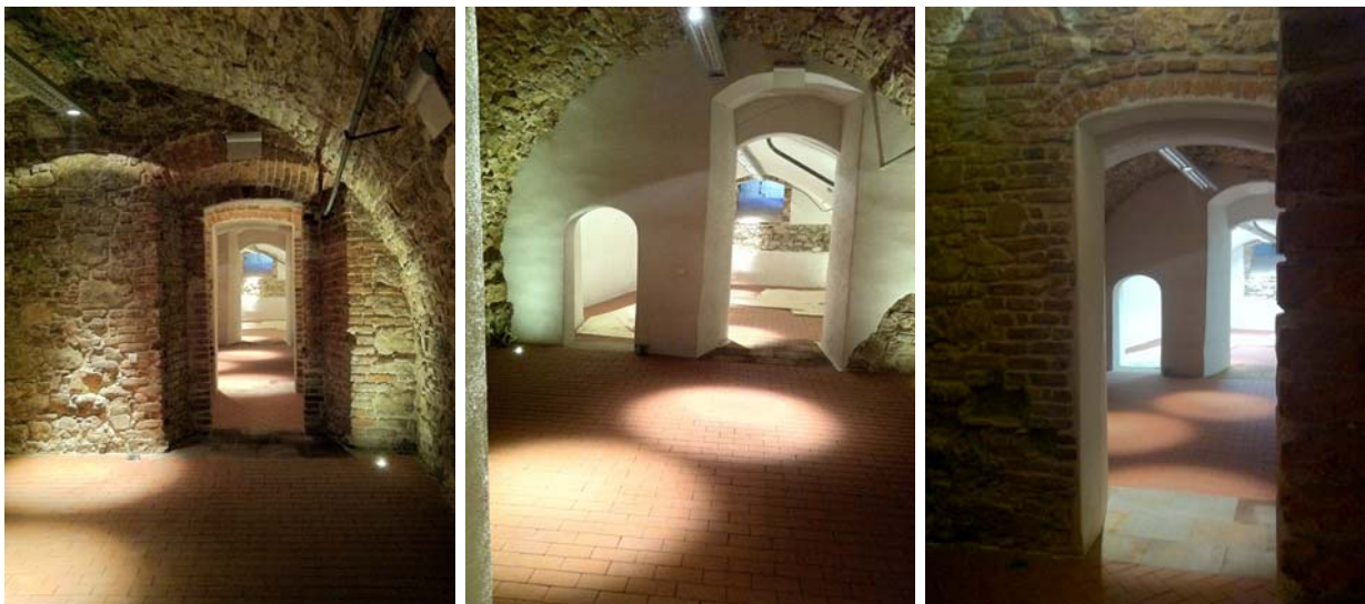
Ryc. 4. a,b,c. Piwnice po wykonaniu prac – górny poziom, przeznaczony na działalność wystawienniczą. Fot. M. Piórkowski Fig. 4. a,b,c. Cellars after the work was completed – upper level intended for exhibition purposes. Photo: M. Piórkowski
