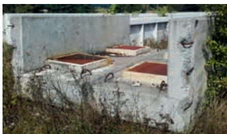
Prefabrykowane bloki podłożyskowe pod konstrukcją odciążającą
