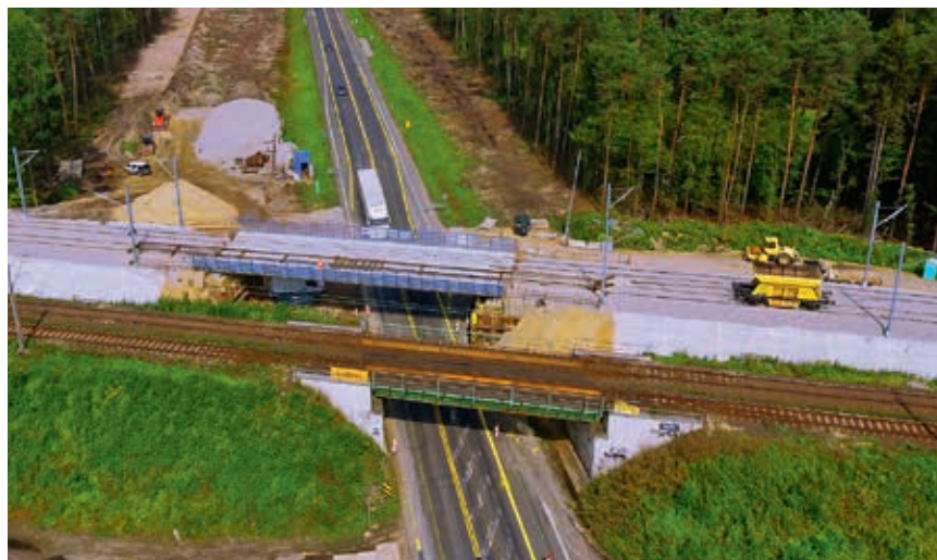
Budowa bajpasu przy WK-1 na S17, odcinek 3, Kołbiel – Garwolin
