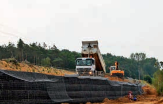
Budowa bajpasu przy WK-9 na obwodnicy Jarocina
