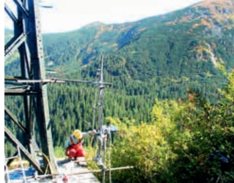
Wzmacnianie fundamentów nowej kolejki na Kasprowy Wierch
