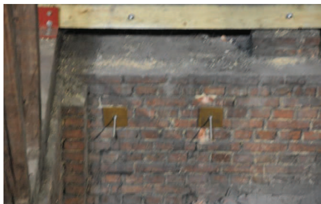
Rys. 12. Naprawiony gzyms – widok od wewnątrz
