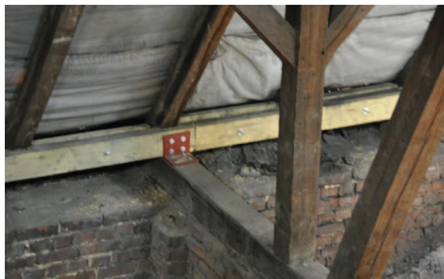
Rys. 8. Widok naprawionych murlat – nakładki oraz kątownik 160 x 160
