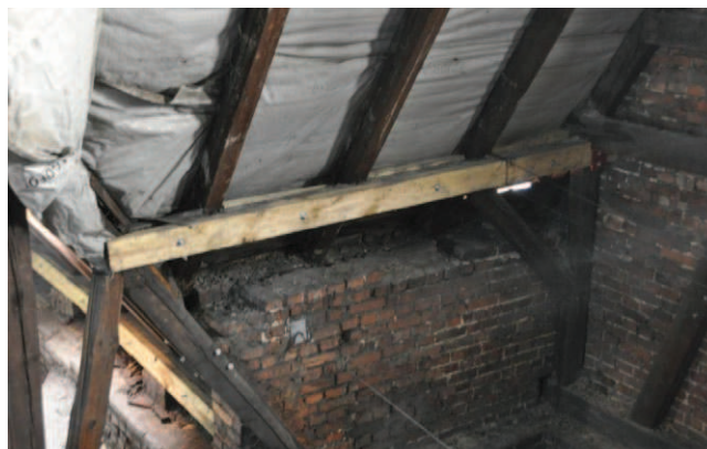
Rys. 9. Widok naprawionych murlat za pomocą nakładek i śrub
