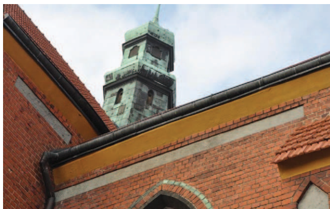
Rys. 11. Naprawiony gzyms – widok od zewnątrz
